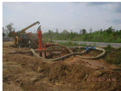
(6) การวางท่อฯ ด้วยวิธีเจาะลอด (HDD)
