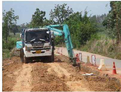
(4) การวางท่อฯ ด้วยวิธีขุดเปิด (Open cut)
