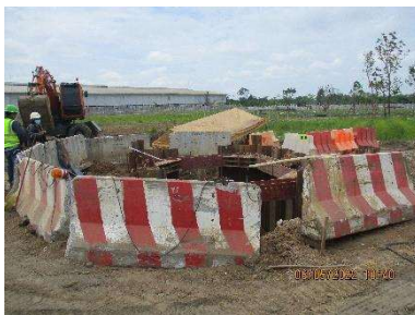
(6) การเตรียมบ่อรับ-บ่อส่งก่อนเริ่มการวางท่อฯ ด้วยวิธีเจาะลอด (HDD)
