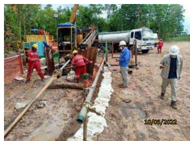
(6) การเตรียมบ่อรับ-บ่อส่งก่อนเริ่มการวางท่อฯ ด้วยวิธีเจาะลอด (HDD)
