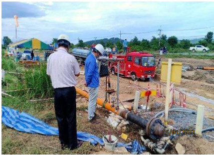
(8) การทดสอบท่อด้วยวิธีทางชลสถิต (Hydrostatic Test)
