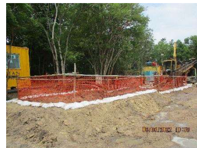
(6) การเตรียมบ่อรับ-บ่อส่งก่อนเริ่มการวางท่อฯ ด้วยวิธีเจาะลอด (HDD)
