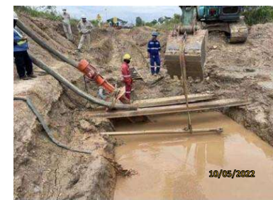
(6) การเตรียมบ่อรับ-บ่อส่งก่อนเริ่มการวางท่อฯ ด้วยวิธีเจาะลอด (HDD)
